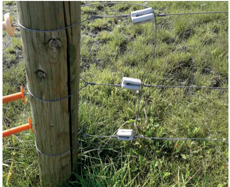
Bild 3: Eckpfosten mit zugfesten Porzellanisolatoren.
