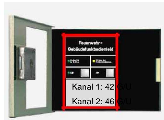
Bild Bild 1: Feuerwehr-Gebäudefunkbedienfeld nach DIN 14 663
