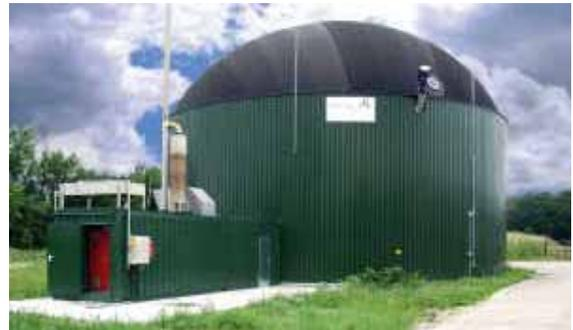
Bild 2: Ansicht einer Biogasanlage mit Gasspeicher und BHKW
