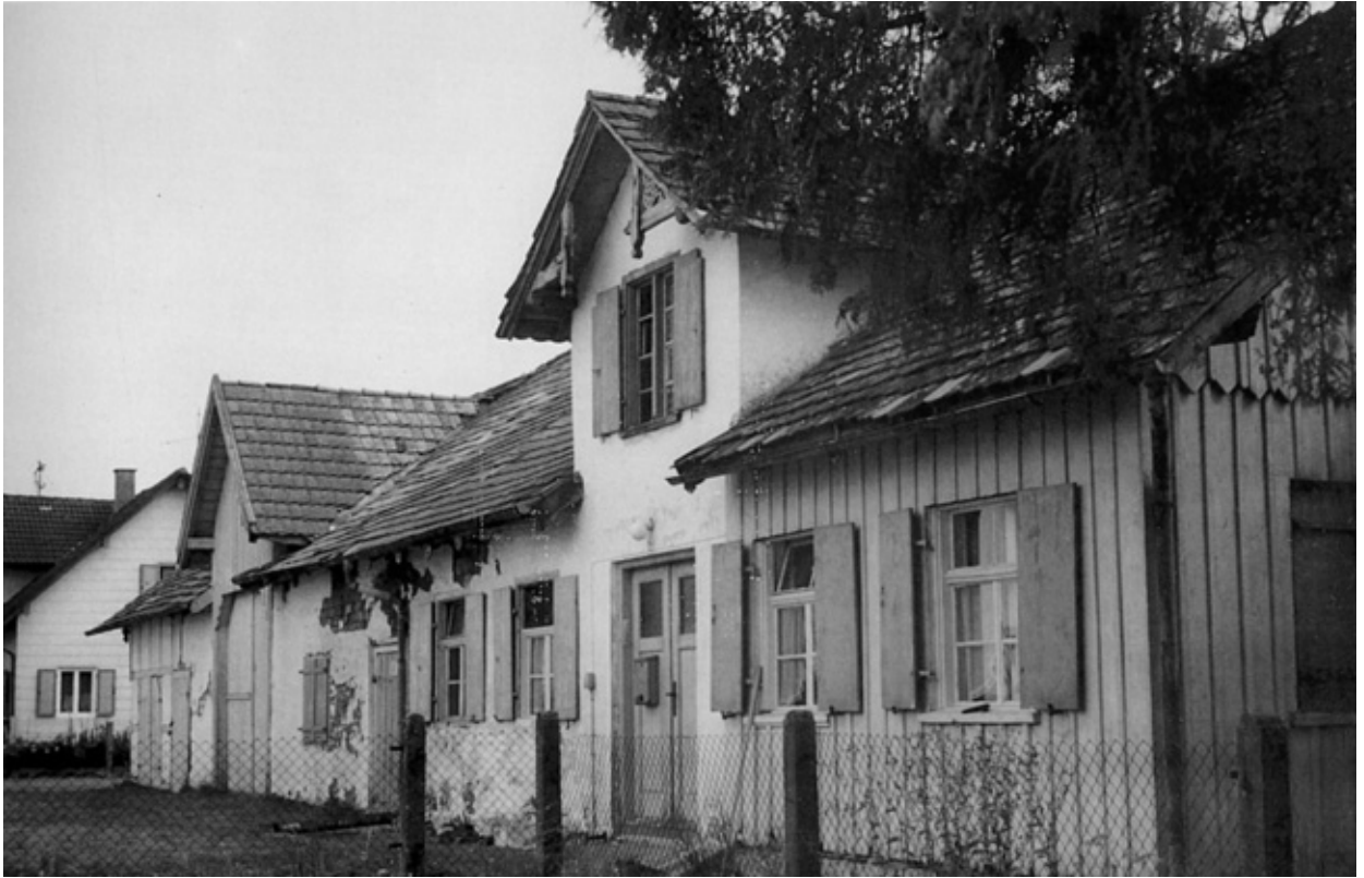
4 Altes Flößerhaus in Aitrach, abgebrochen 1998.
