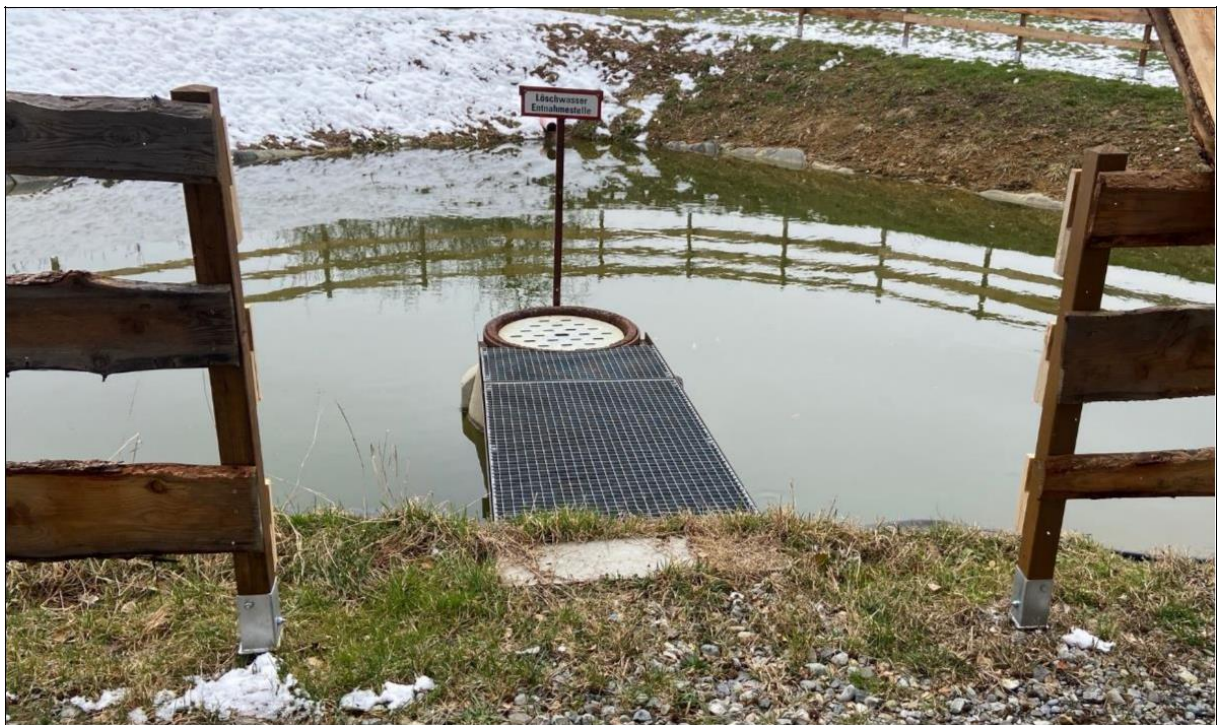
Abbildung 10: umfriedeter Löschwasserteich mit Saugschacht in Aitrach
