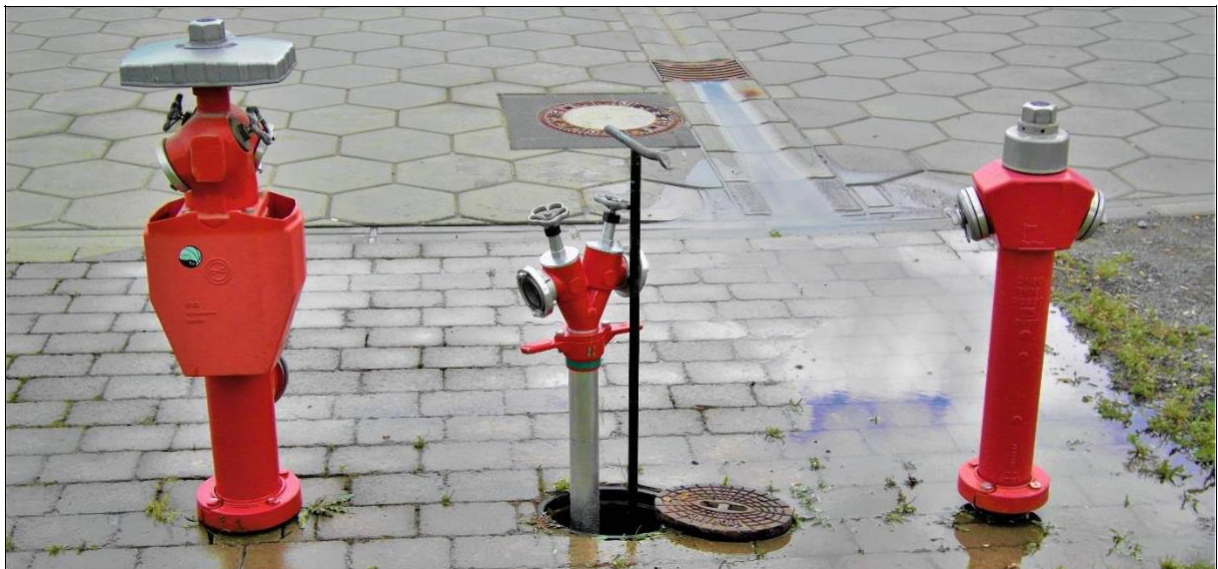
Abbildung 6: v. l. n. r. Überflurhydrant mit Fallmantel, Unterflurhydrant + Standrohr + H.-schlüssel, Überflurhydrant
